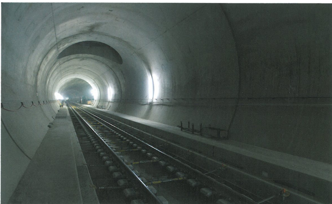
1 Der Gotthard-Basis-Tunnel im Schweizer Kanton Uri – Vorzeigeeobjekt einer erfolgreichen technisch komplexen Planung
